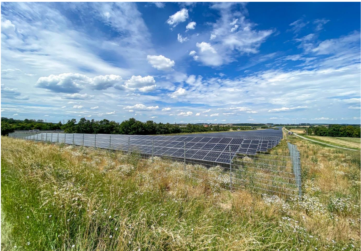
Abb. 7: Beispiel Einfriedung einer PV-FFA (Foto: EE-Plan April 2020)
